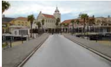
連絡通路の上から見た建築物
