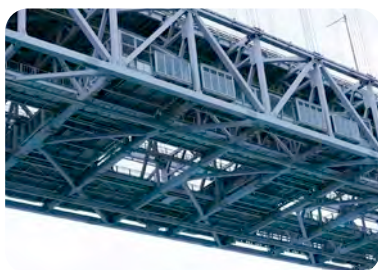
大鳴門橋の下部に設けられた展望施設
