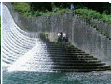
左岸端部は階段状
