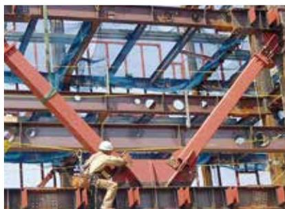
写真3 折返しブレースの取付状況
