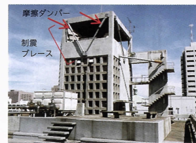
写真4 日大5号館4階建て塔屋の外観
