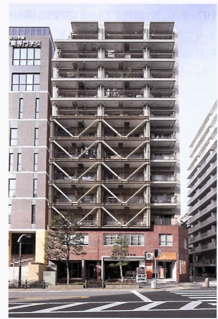
写真3 集合住宅への制震プレース適用事例
