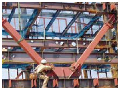
写真3 折返しブレースの取付状況
