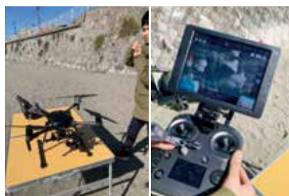
ドローンを活用した調査の様子
