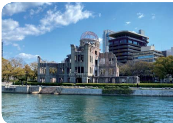
元安川からの原爆ドーム全景 雁木とのつながりが分かる
