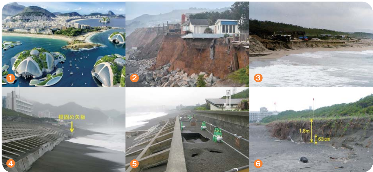
① 海洋建築物のイメージ ② 侵食してしまった砂浜の様子① ③ 侵食してしまった砂浜の様子② ④ 緩傾斜護岸の前面の様子 ⑤ 緩傾斜護岸の天端の様子 ⑥ 浜崖の様子
