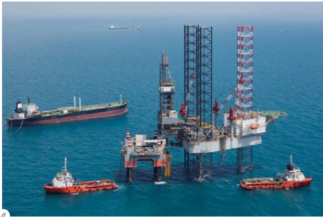
据付中のジャッキアップリグ
