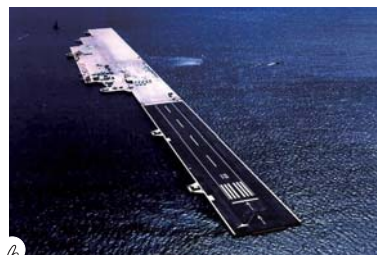
浮体式空港の実証実験
