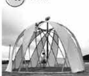
建物の内装と広場の日除けに竹を用いる
