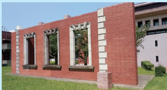
三菱一号館モックアップ試験体（船橋キャンパス図書館南側）
